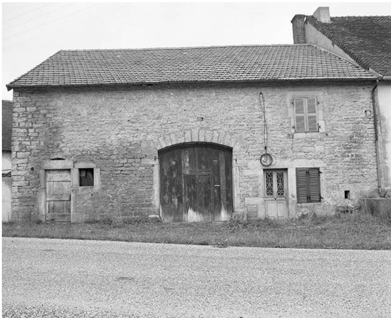
Façade antérieure, de face.
