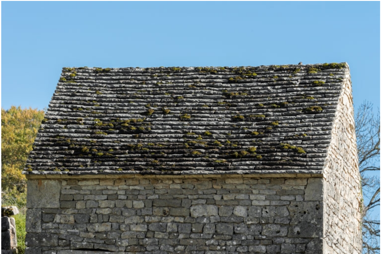
Détail de la toiture côté ouest.
