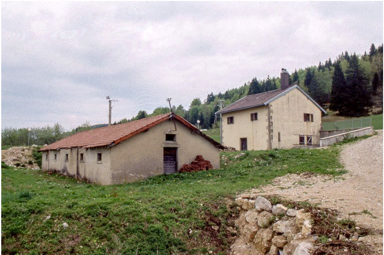
Façades postérieures et latérales gauches de la fromagerie et de la porcherie.
