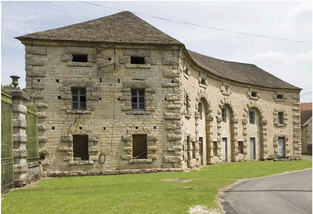
Magasin en quart de cercle depuis le sud-est.
