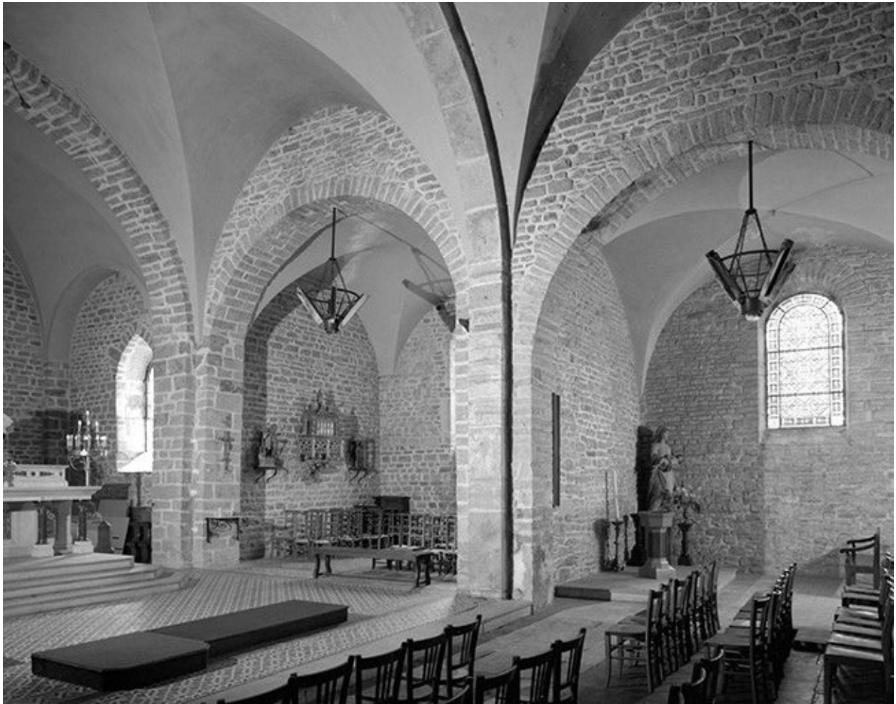
Elévation intérieure droite.
