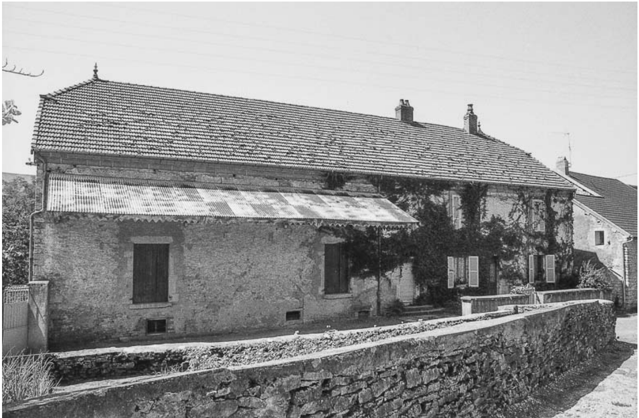
Maison cadastrée 1980 C1 208 : façade antérieure.
