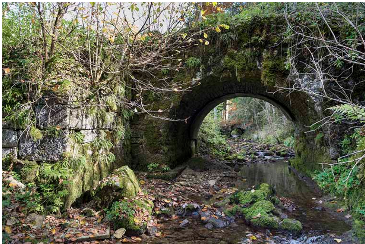
Pont en aval, à l'ouest.
