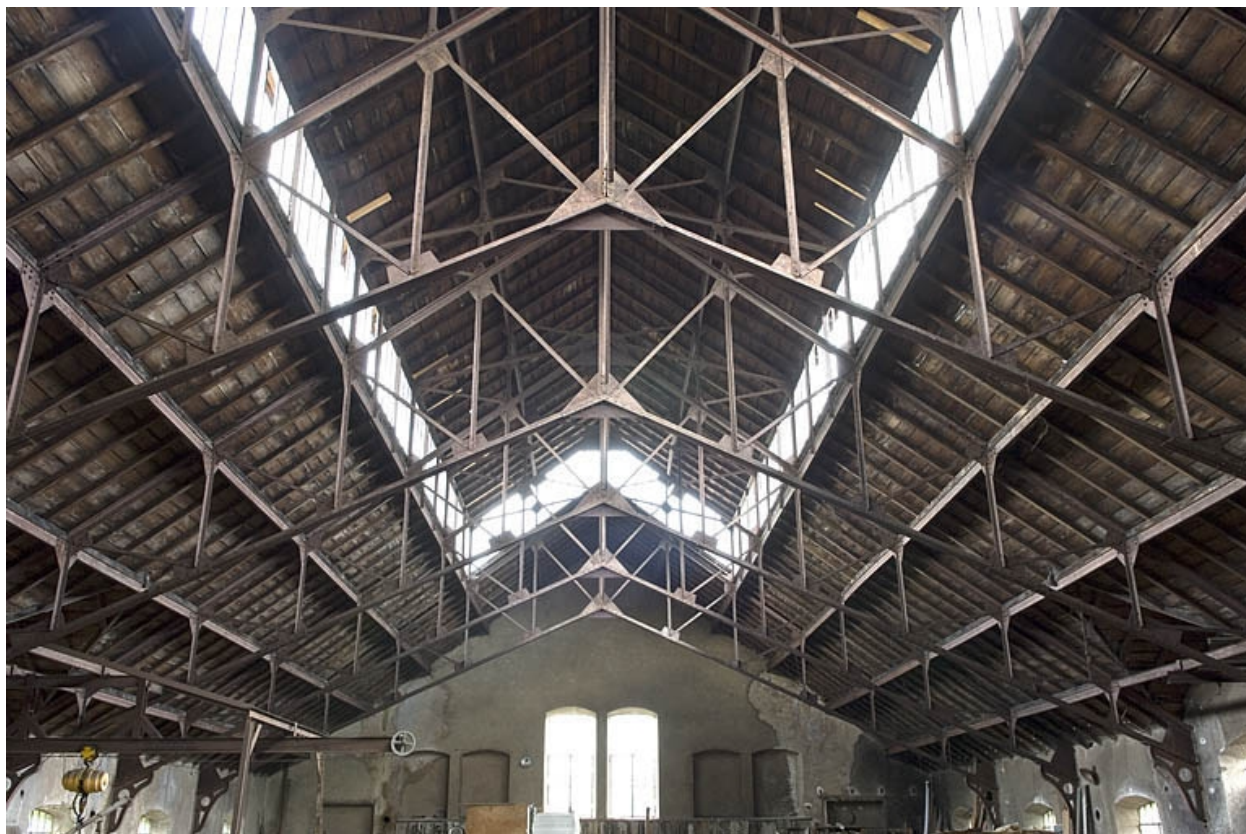
Vue de la charpente métallique.
