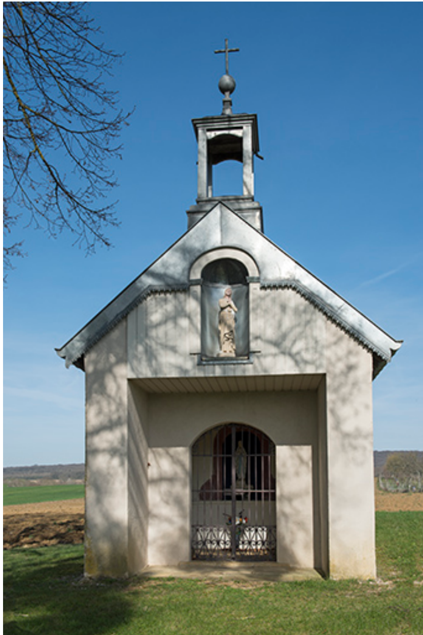
Chapelle saint-Brice. Vue de face.
