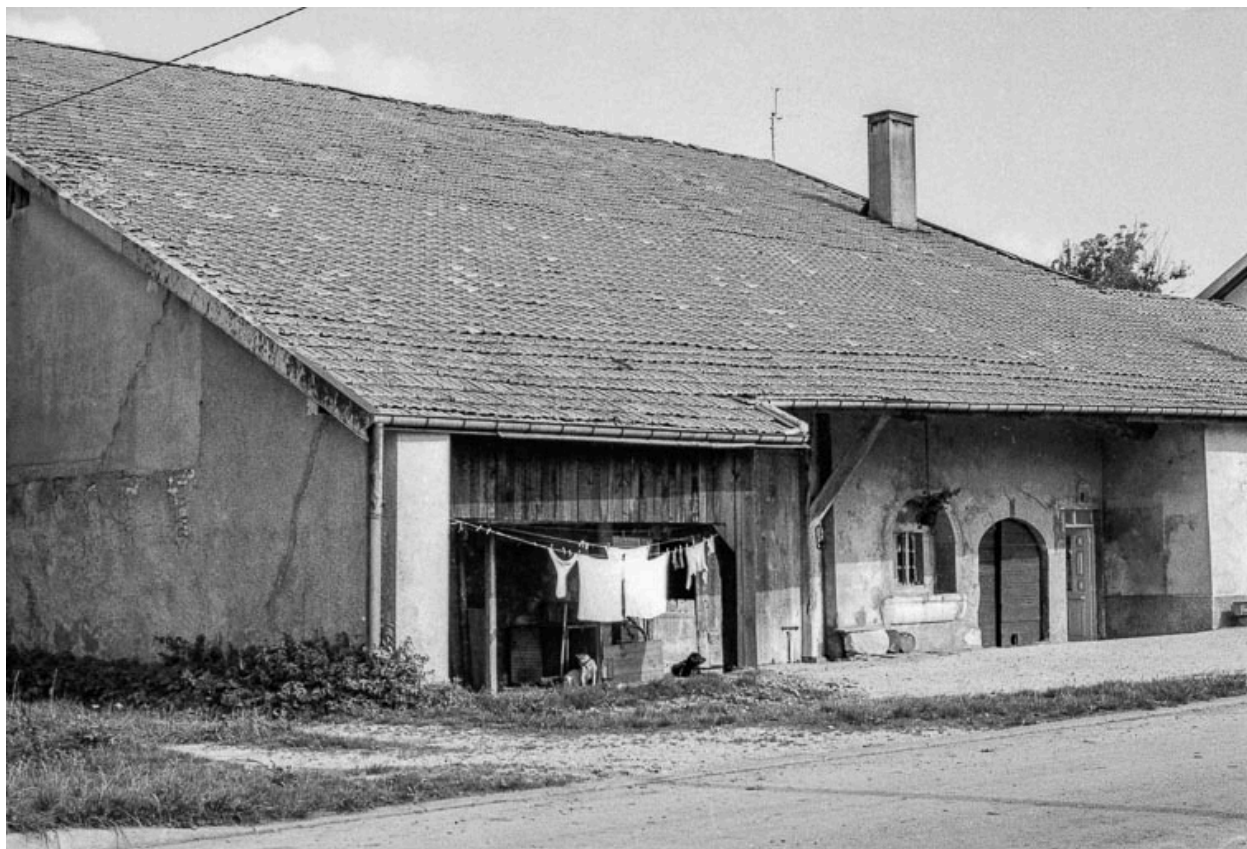
Ferme : façades antérieure et latérale droite.
