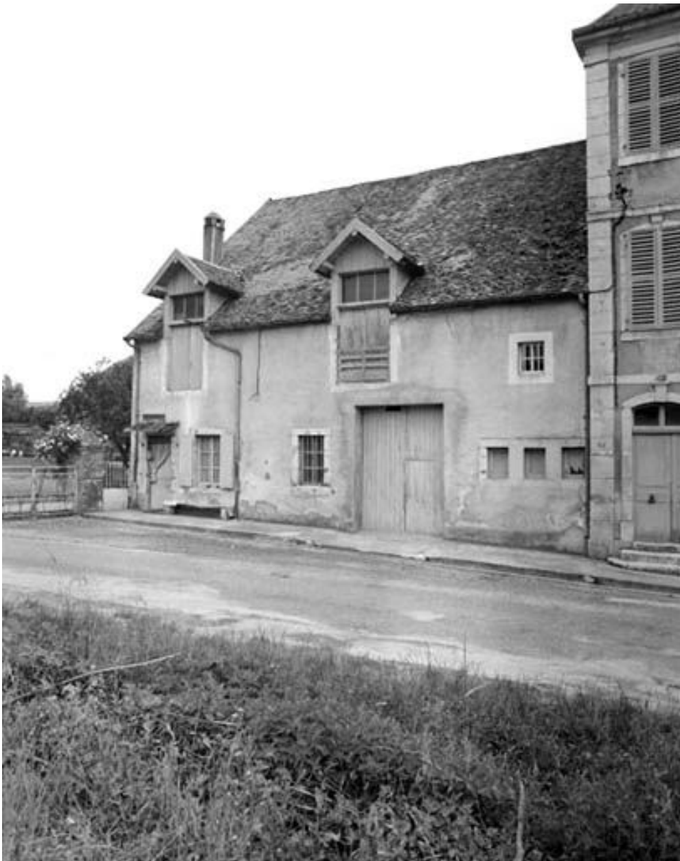
Ferme située 26 rue du Seult.
