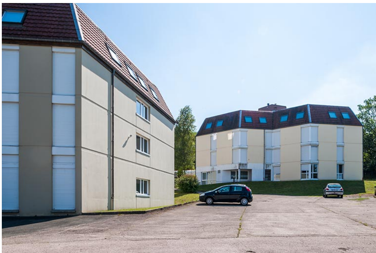
Les bâtiments d'hébergement.
