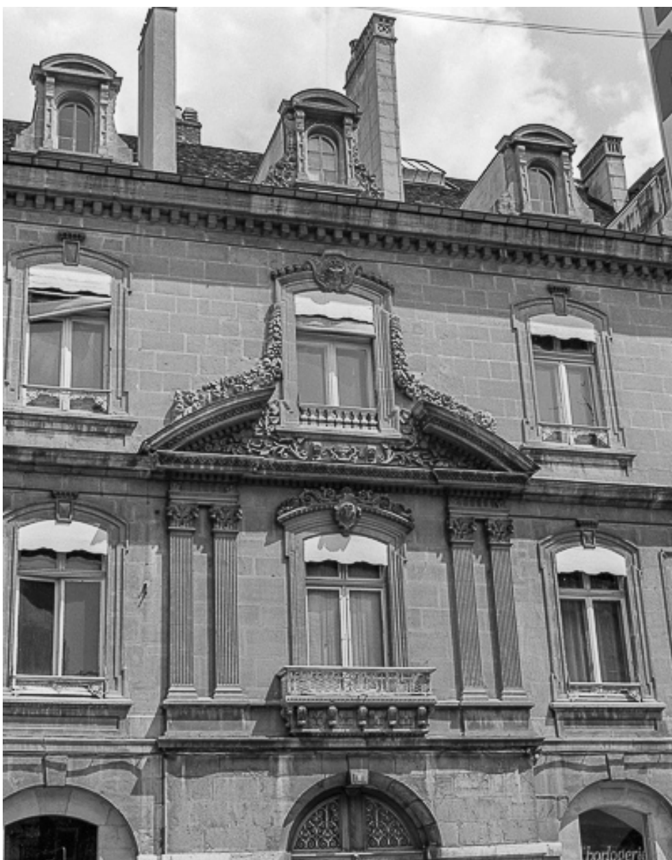
Détail du corps central.
