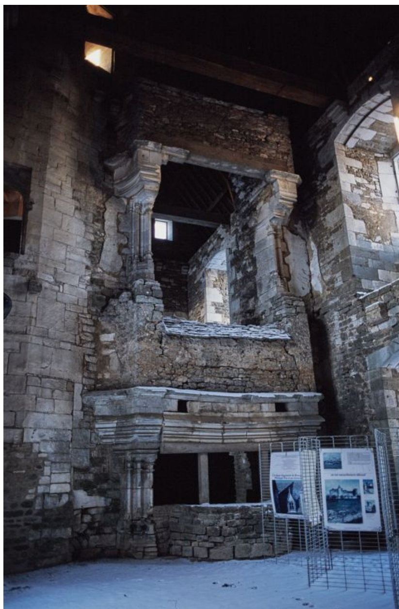
Logis Philippe Pot, partie sud : cheminées superposées.
