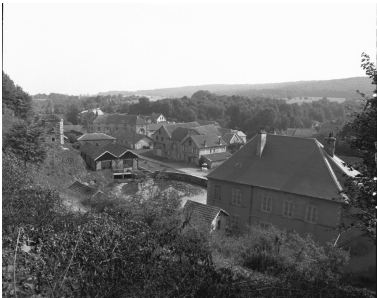
Vue générale plongeante depuis le sud-ouest en 1992.
