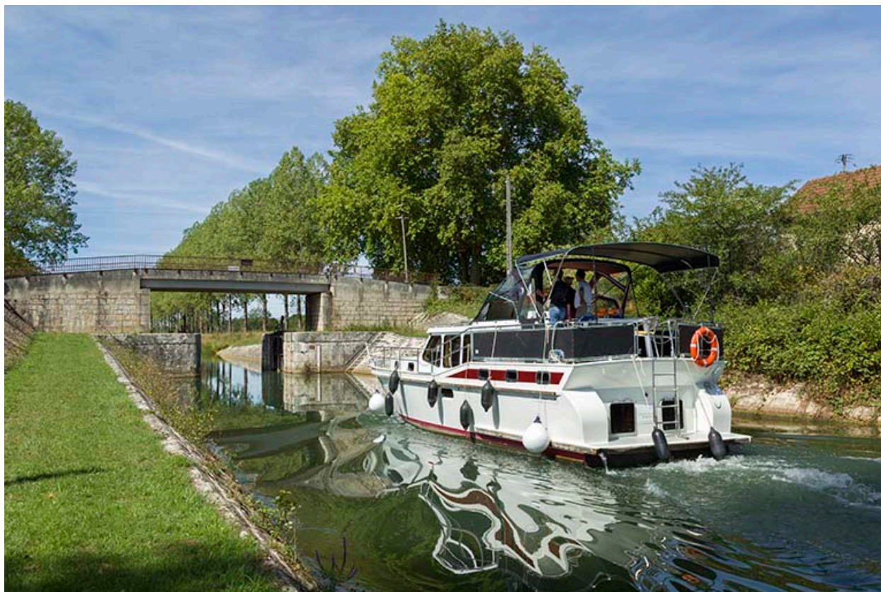
Porte de garde de la dérivation de Rigny (Haute-Saône).
