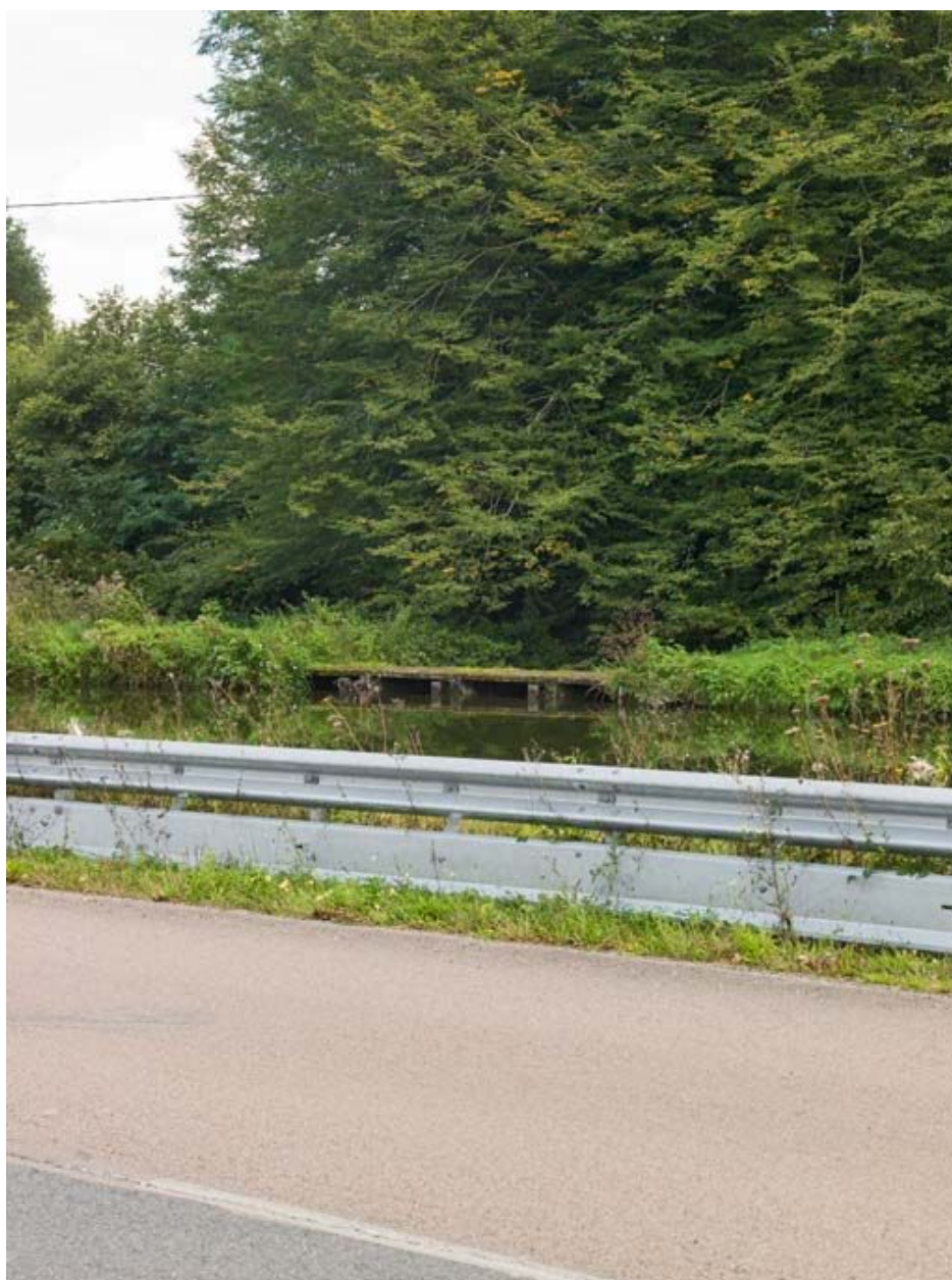
Vue du déversoir.
