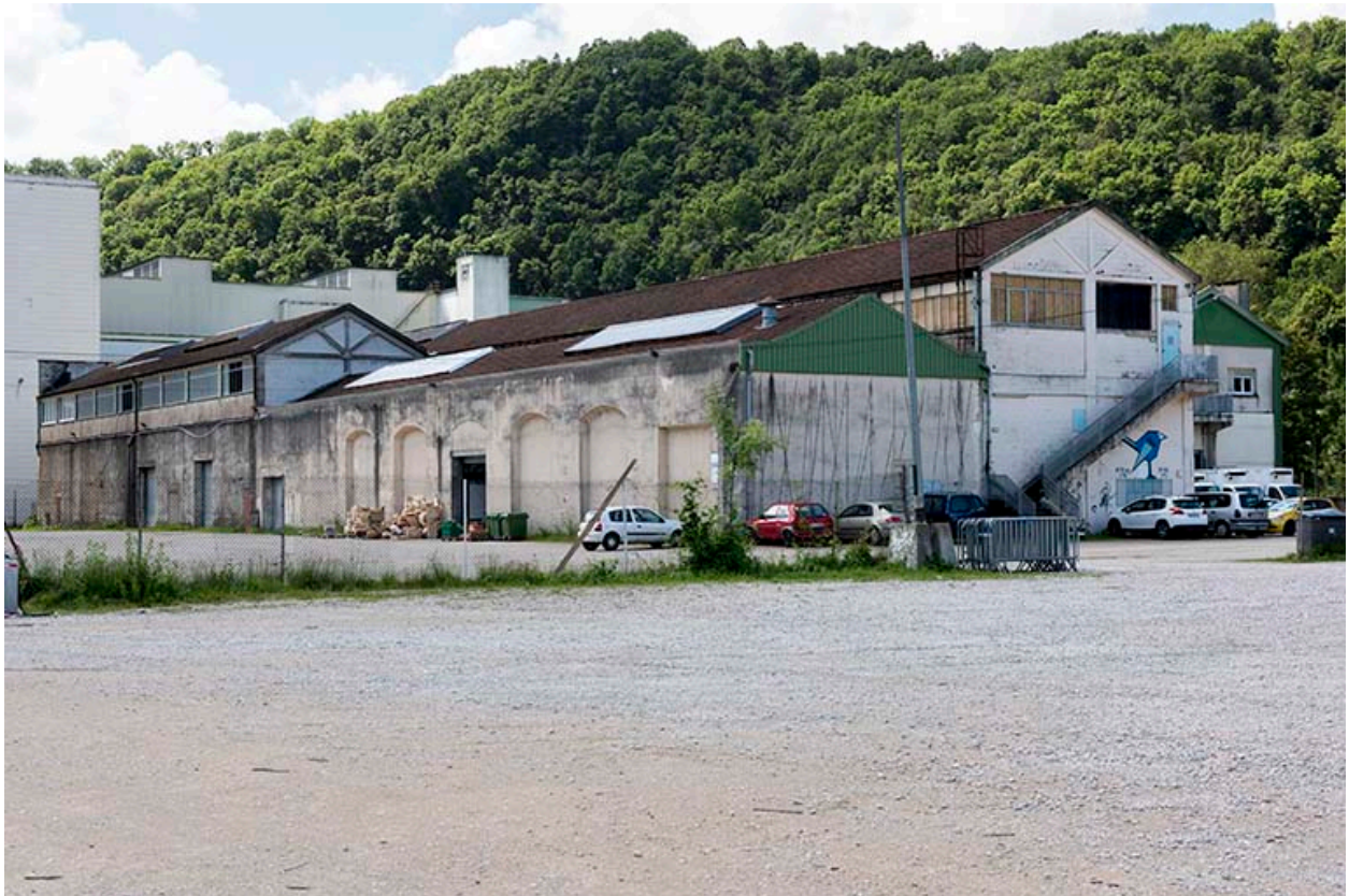
Etat en 2016. Usine B : bâtiments de l'ancienne papeterie.
