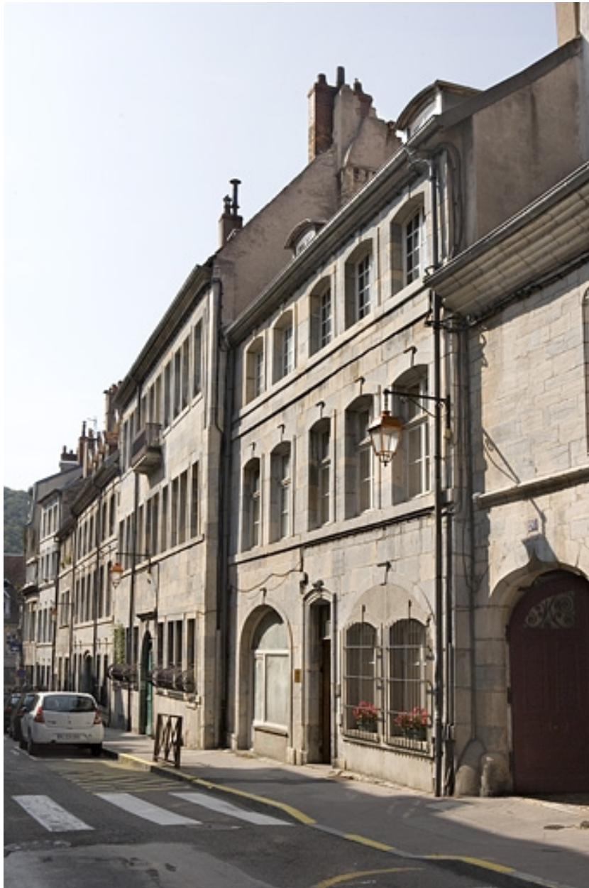
Vue d'ensemble du logis sur rue, de trois quarts droit.
