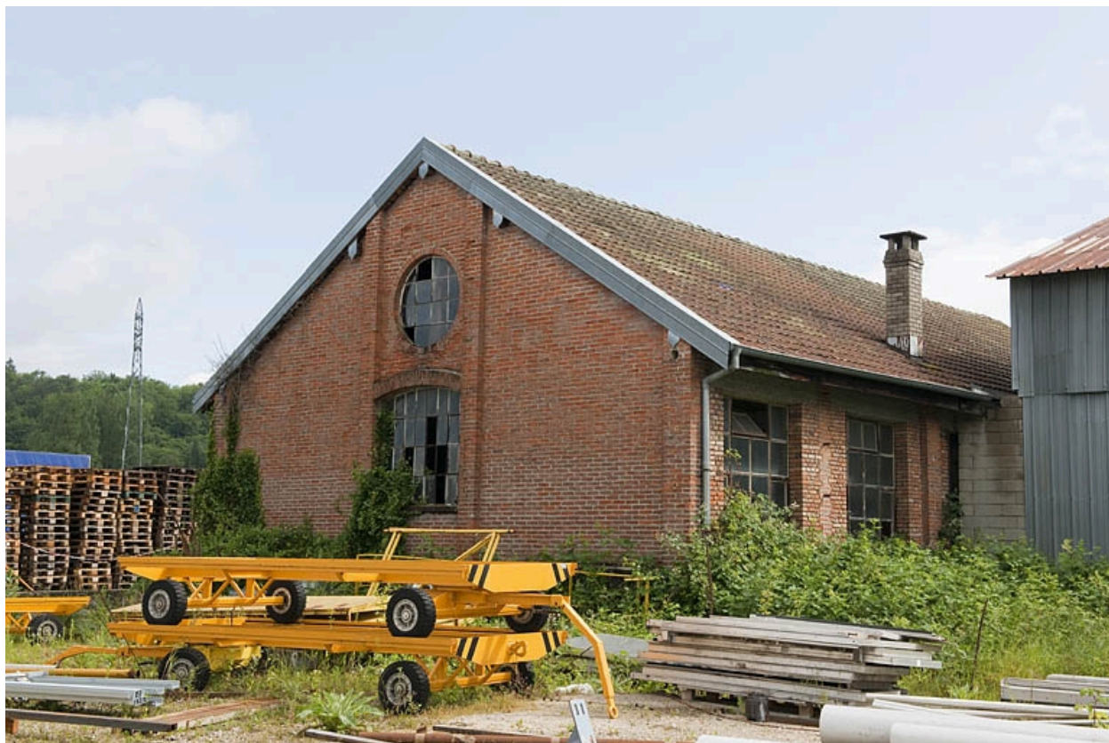
Entrepôt industriel vu de trois quarts arrière.
