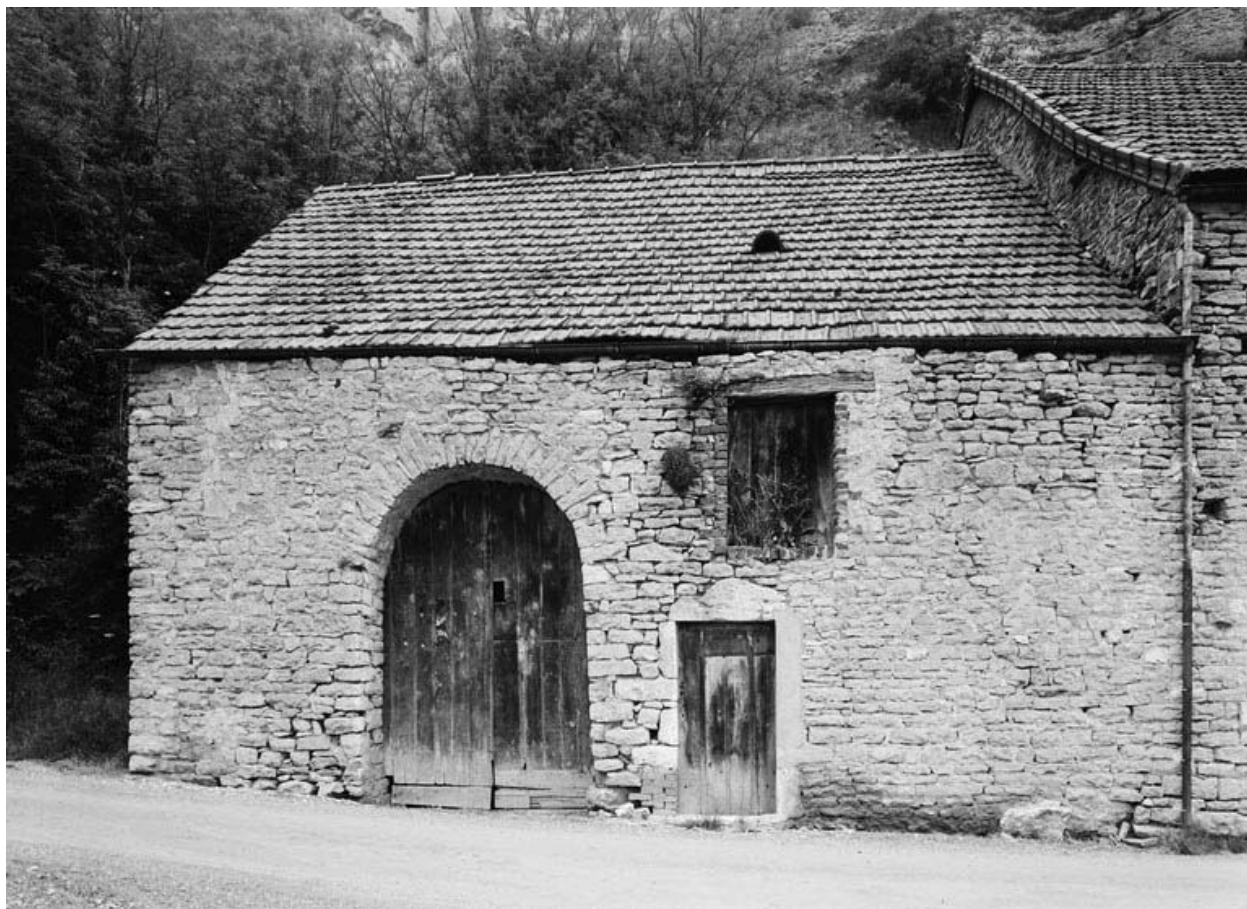
Cuveries (parcelle 71, section B1 du cadastre de 1953).
