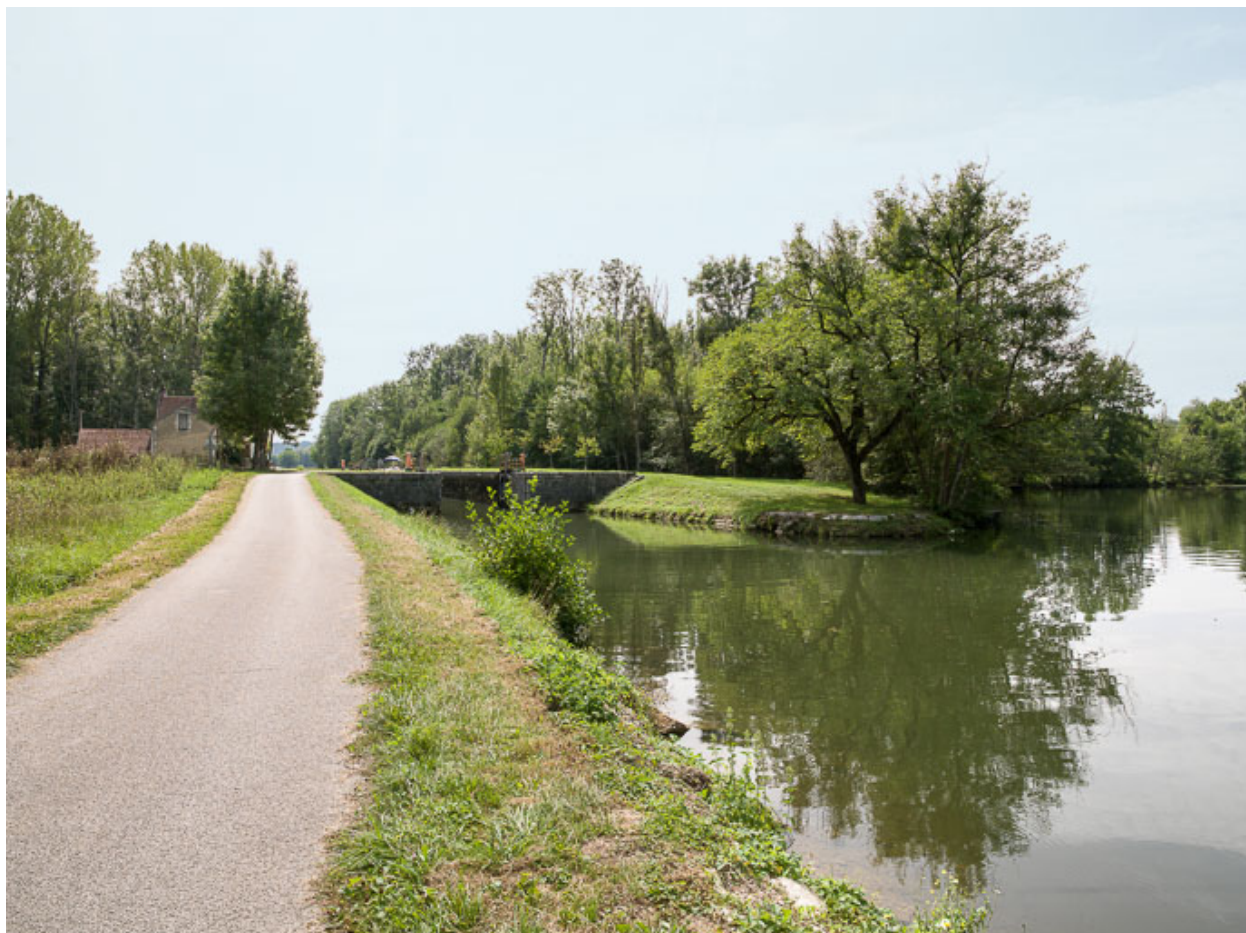
Vue du site d'écluse et de la râcle.
