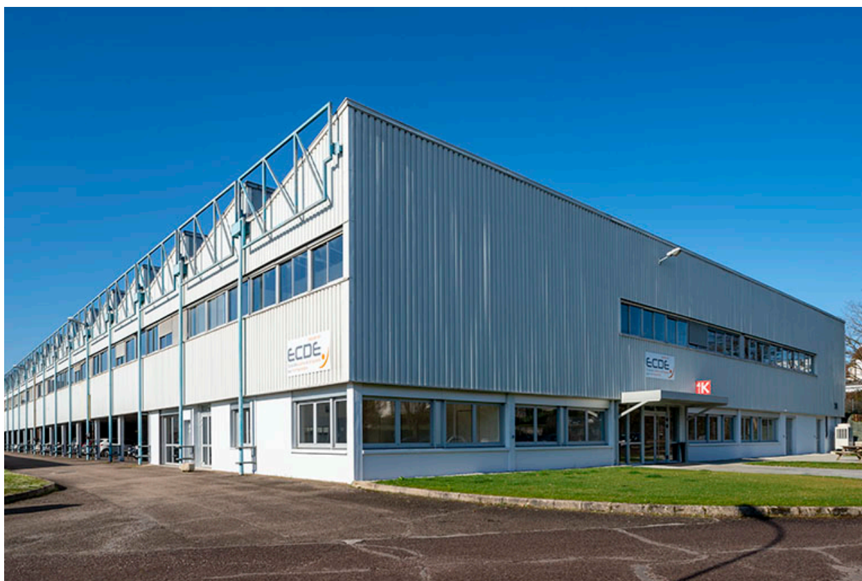
Atelier de fabrication vu depuis le nord-est.
