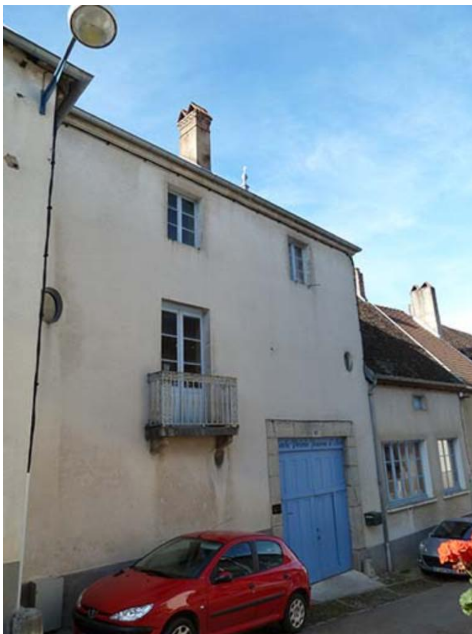
Façade sur la rue du Grand Mont
