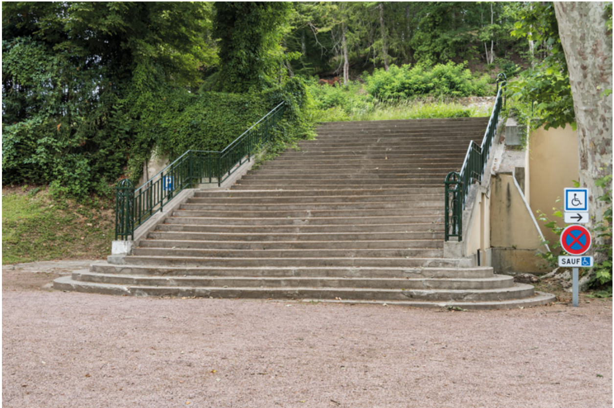
Escalier d'accès depuis le parc, vue depuis l'ouest.
