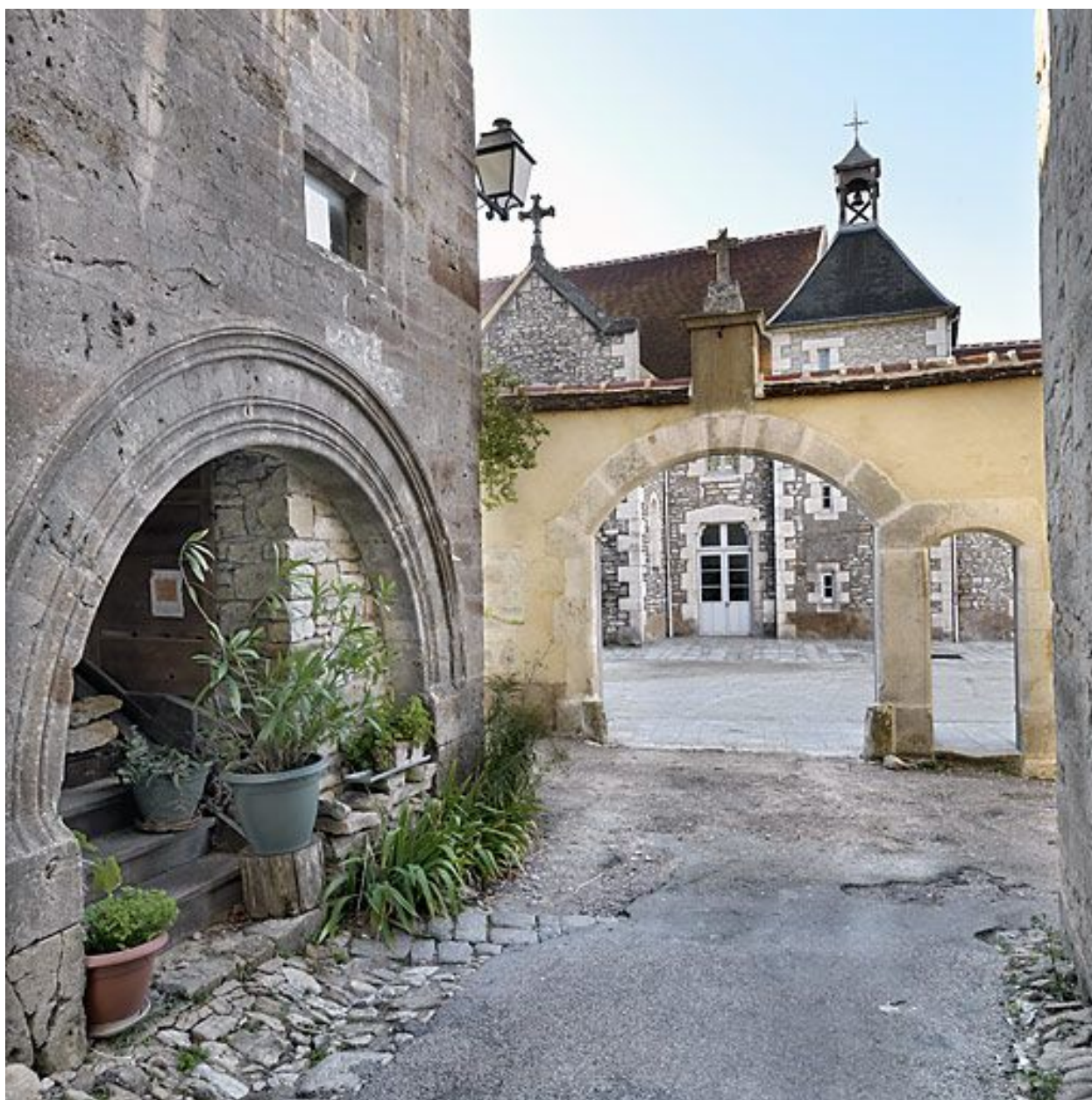
Vue d'ensemble depuis la rue du Couvent.
