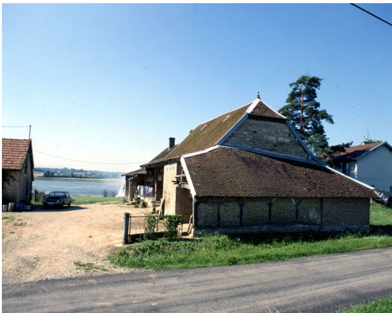
Fontainebrux : ferme située route de Fontainebrux.
