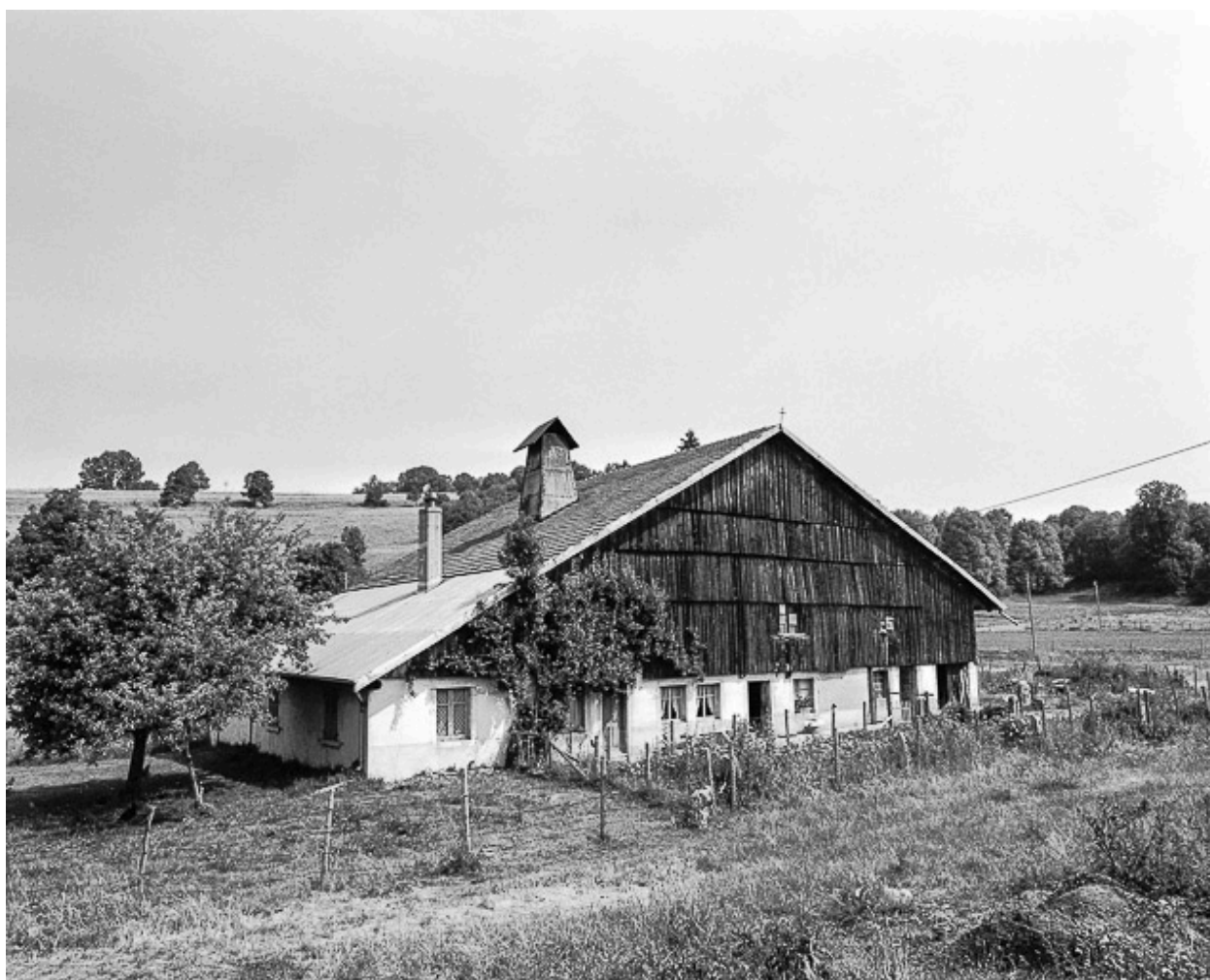
Ferme située au lieu-dit Colombière, cadastrée AB 75 : façade antérieure.
