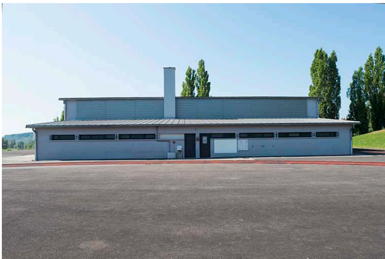
Façade antérieure du gymnase
