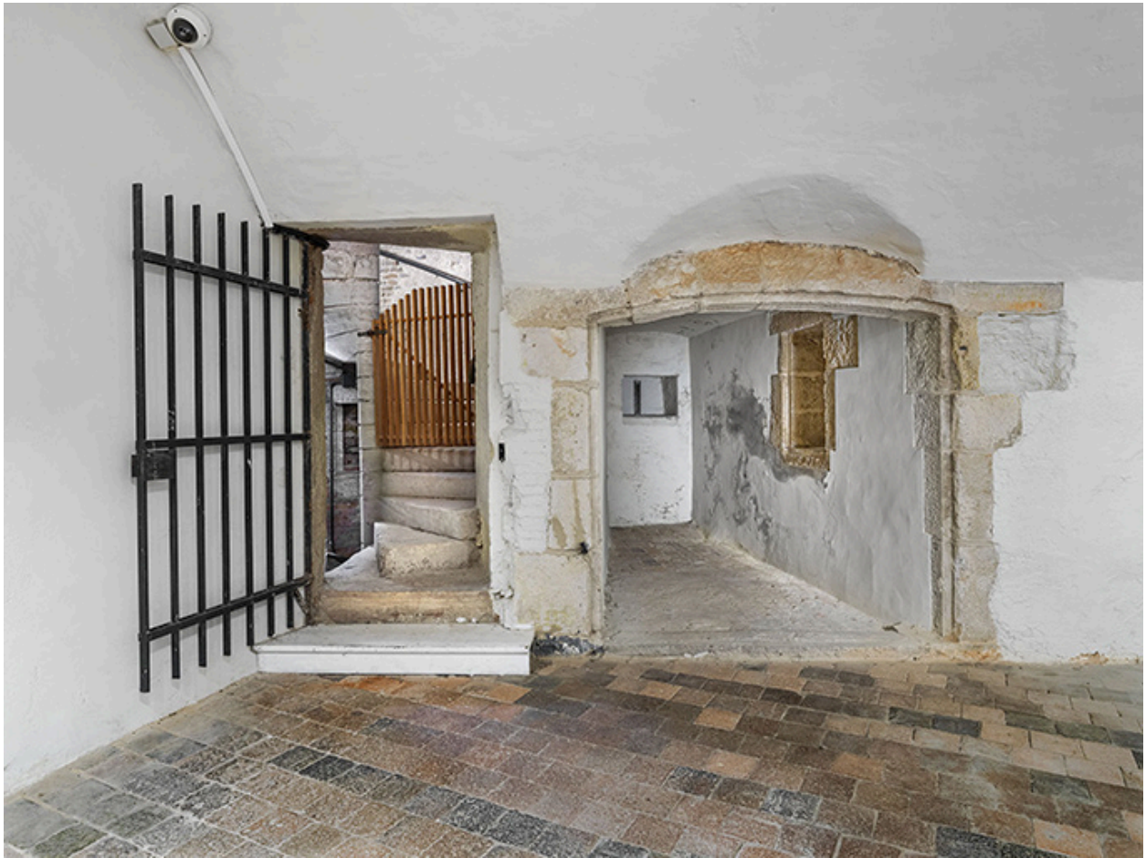
Tour Notre-Dame : porte d'accès au premier niveau.
