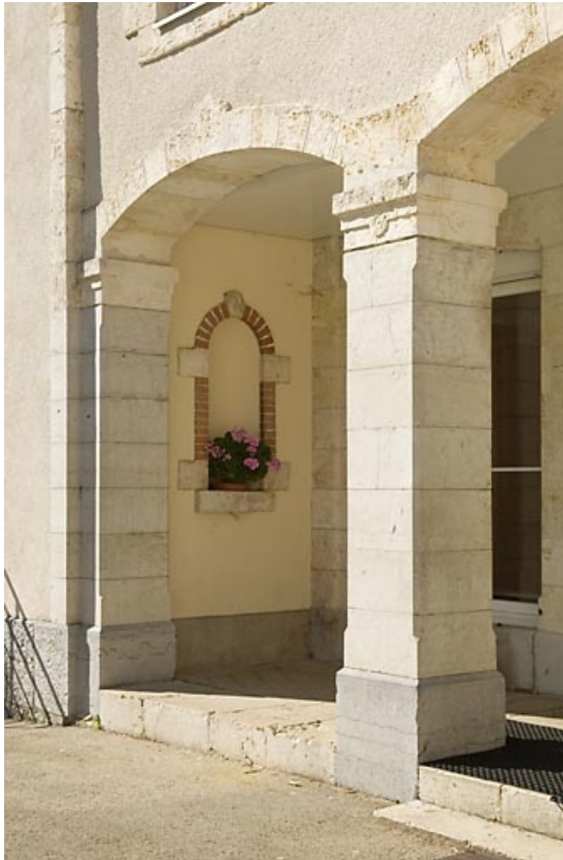
"Grand Château" : détail de la galerie.
