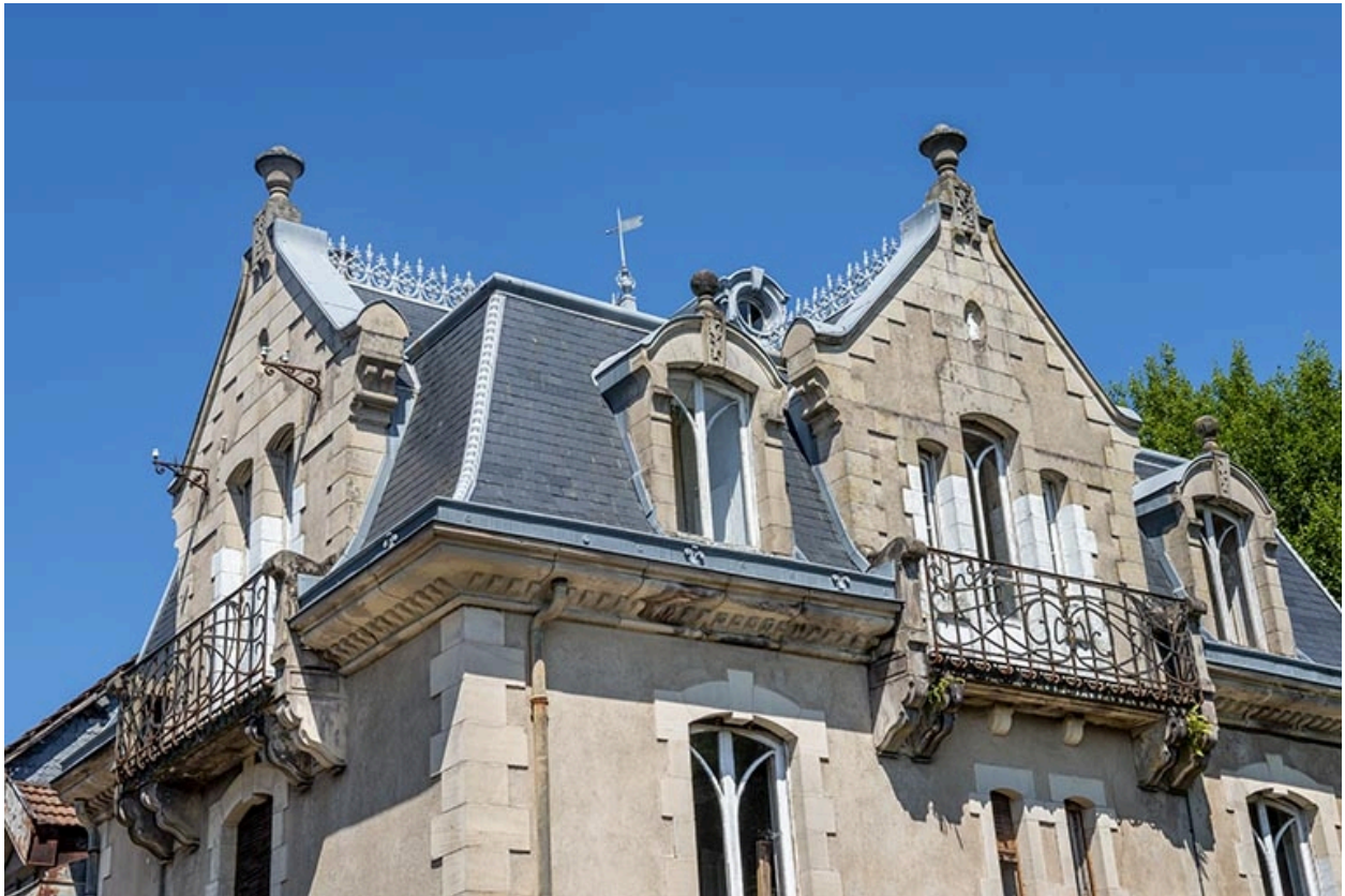
Toiture et lucarnes.
