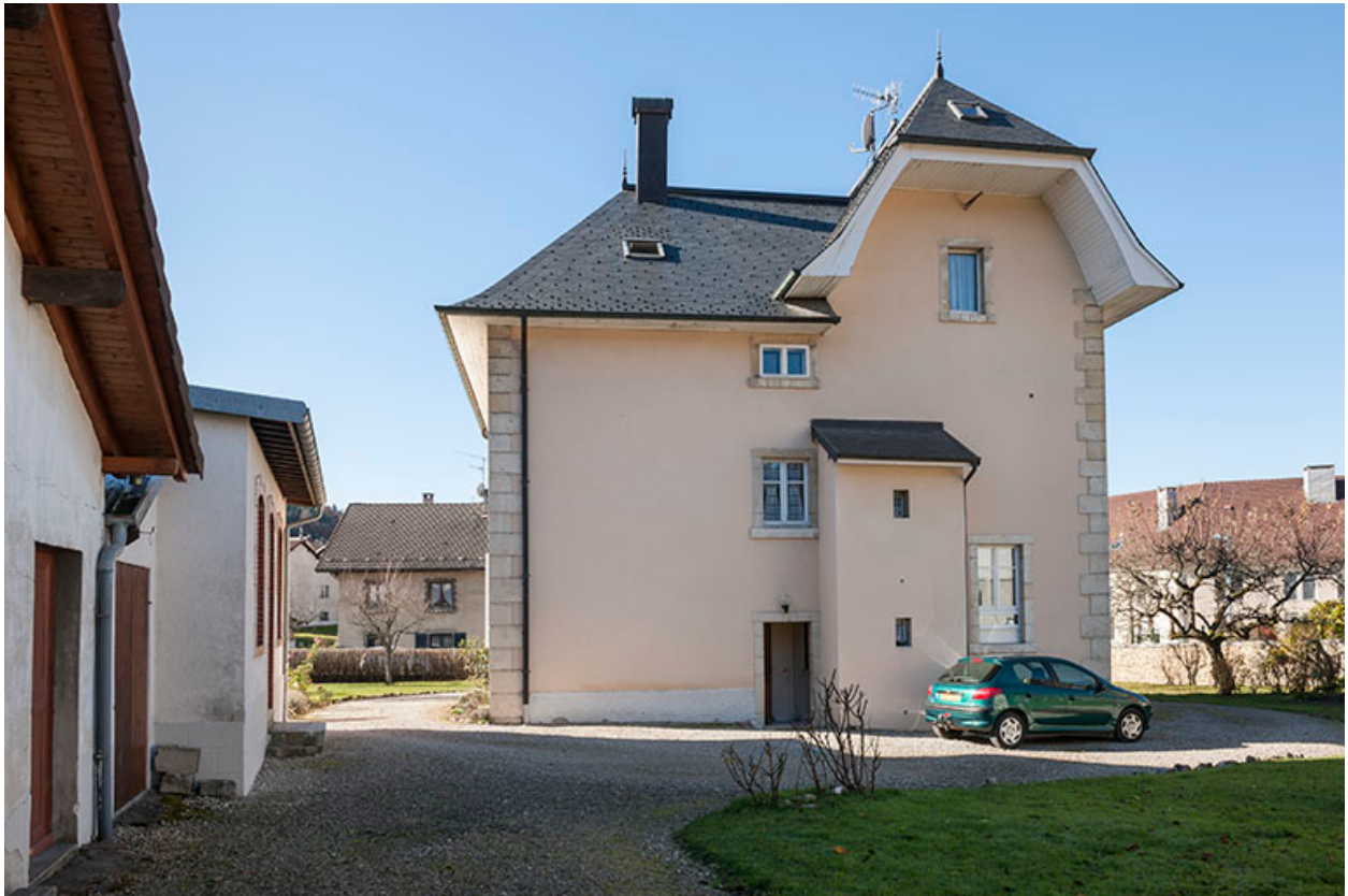
Logement patronal : façade postérieure.
