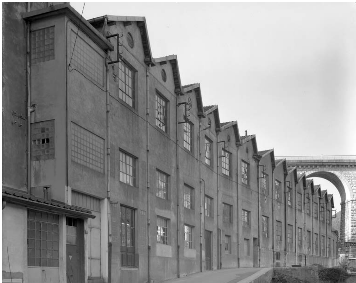
Cristallerie et verrerie Dalloz : façade postérieure de trois quarts gauche.
