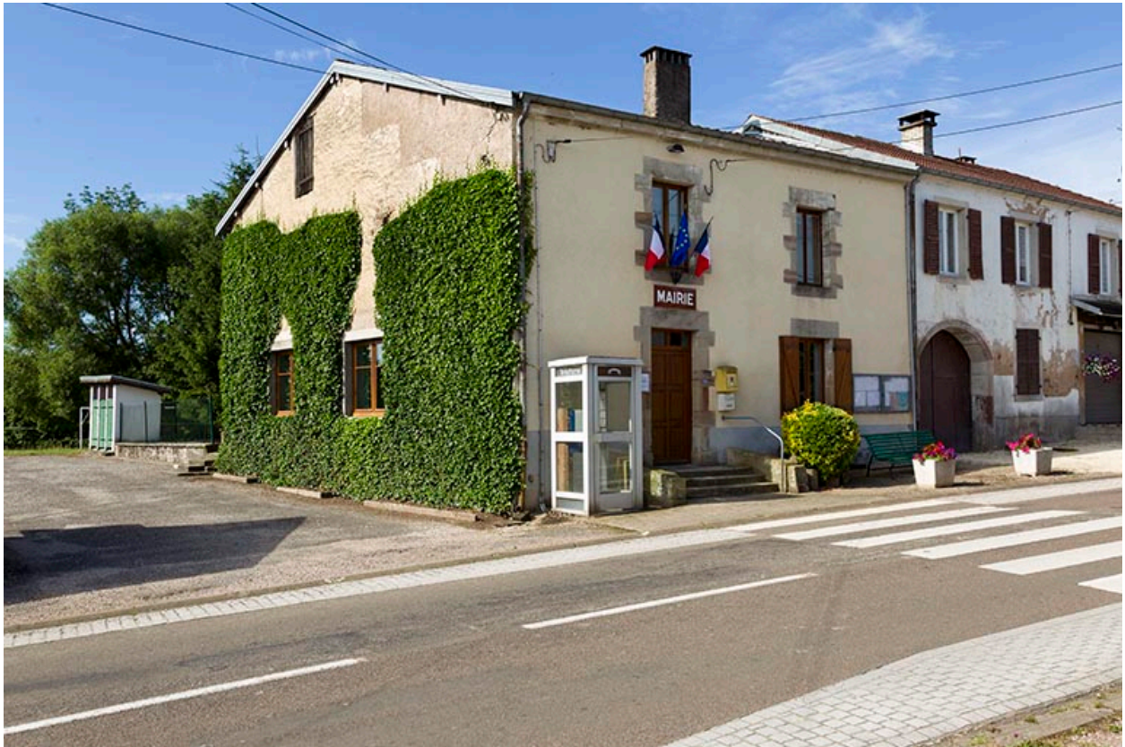
Façades antérieur et latérale gauche.
