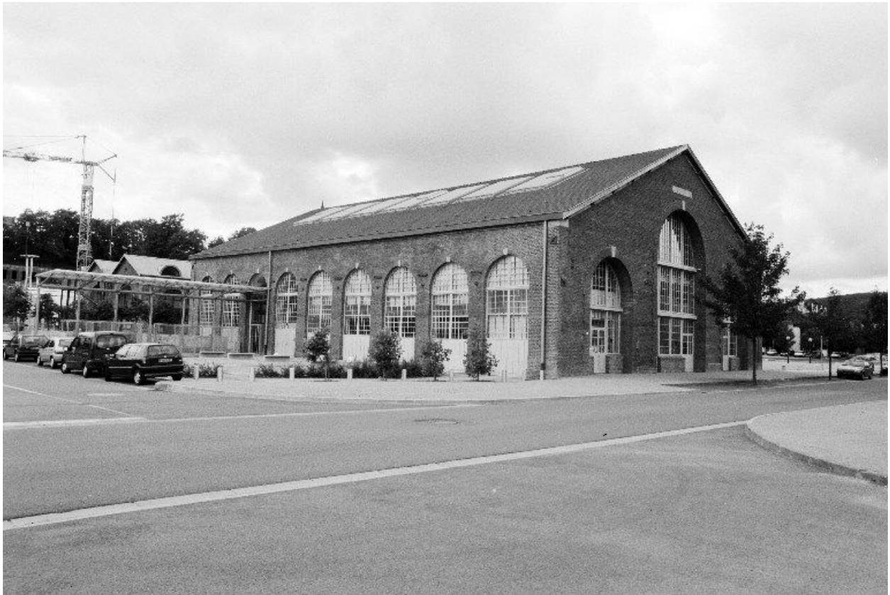
La halle des grues et des locos vue du nord-est.
