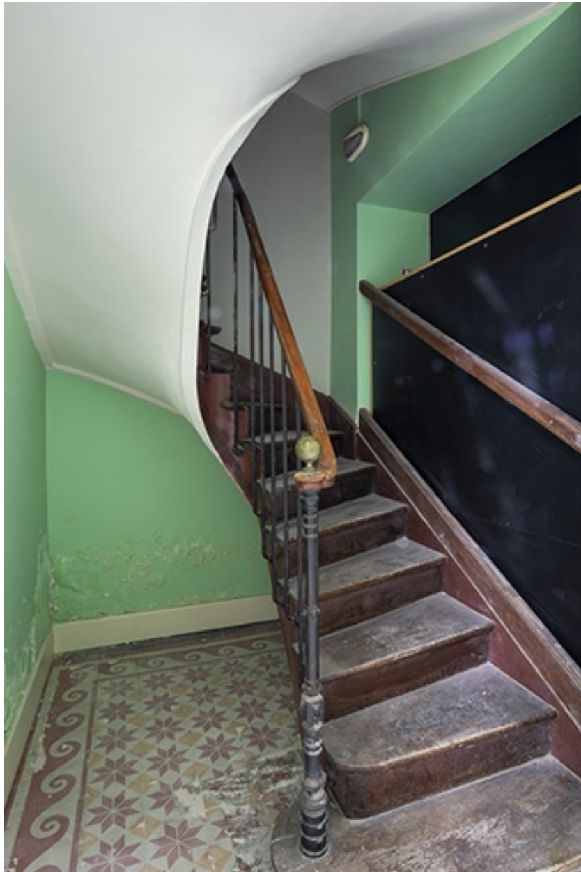
Escalier conduisant aux combles au-dessus de l'ancienne salle d'attente.
