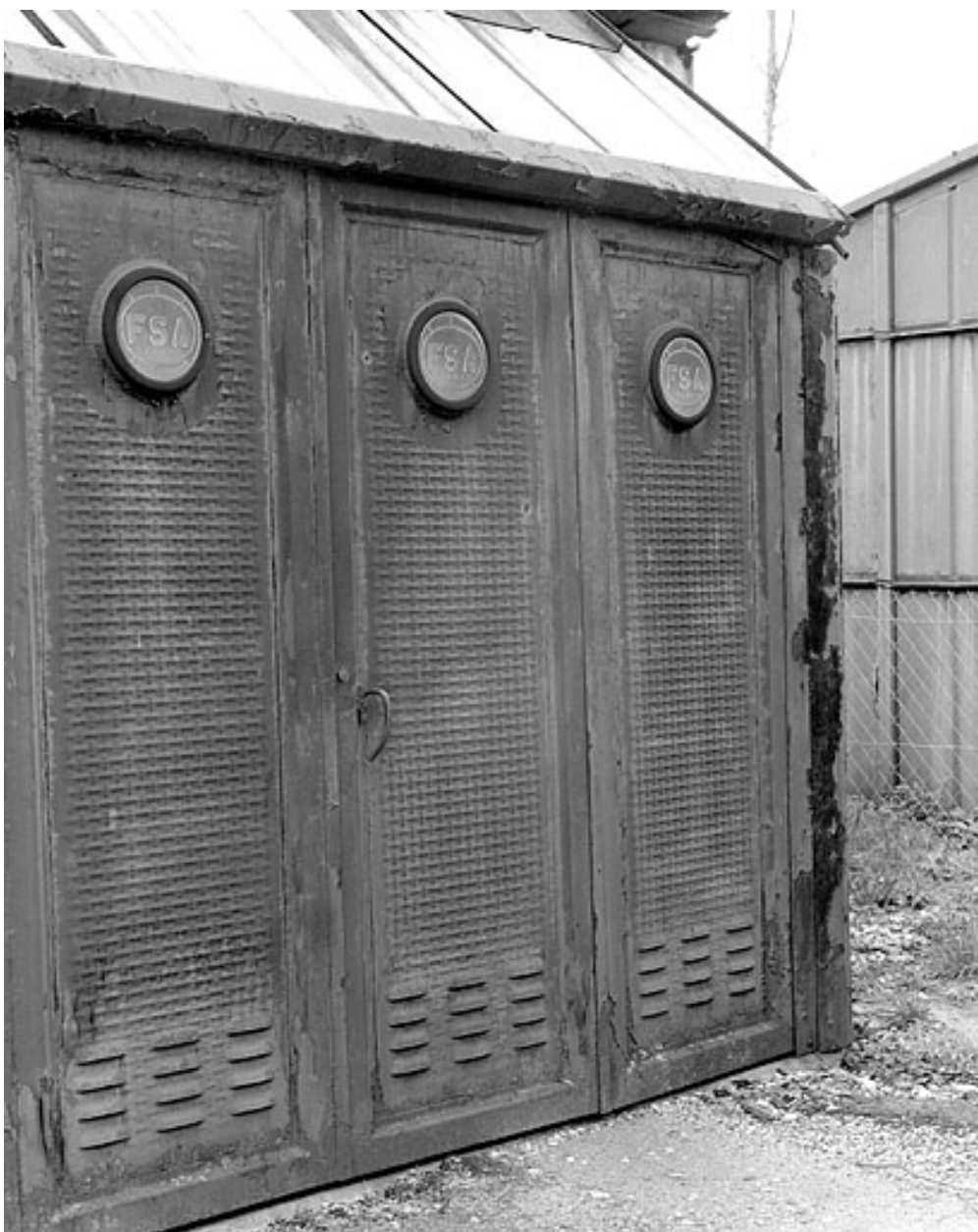
Remise d'automobile métallique : porte d'entrée.
