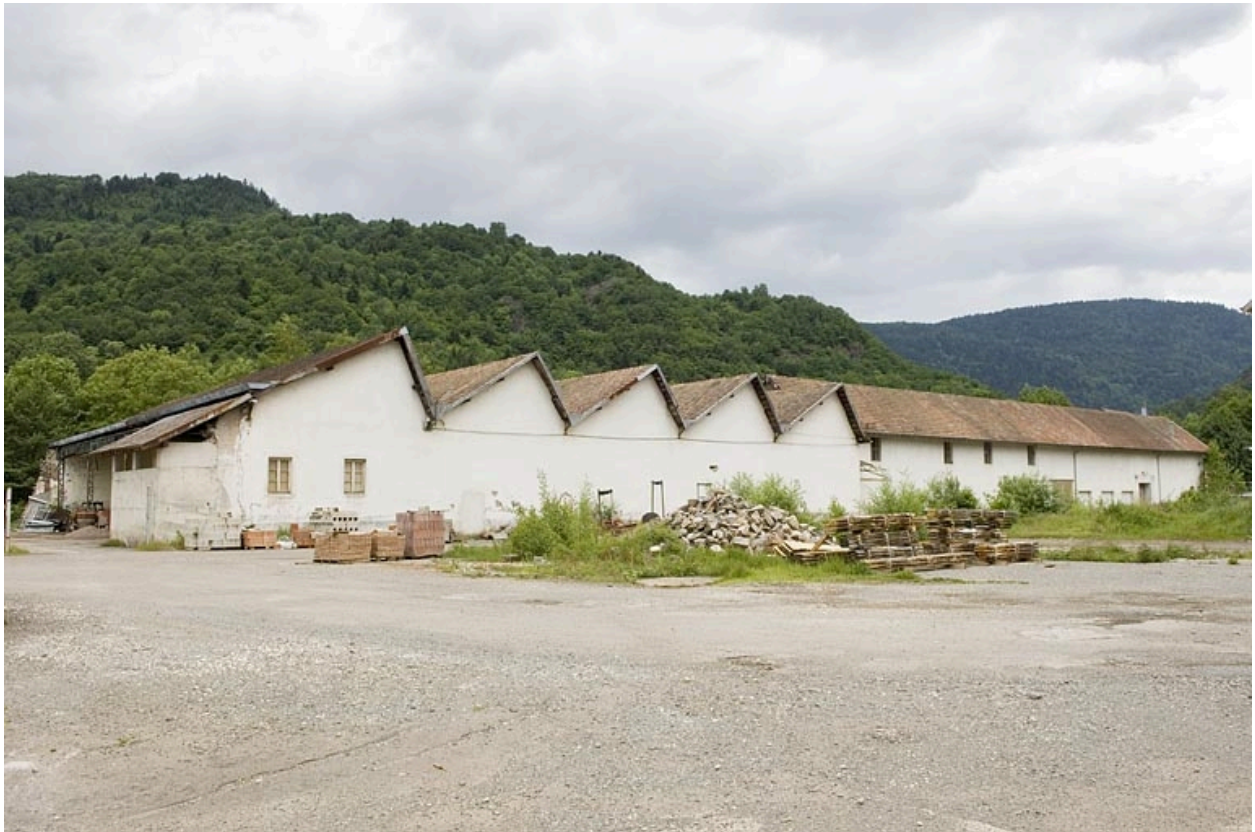
Atelier de fabrication (boulonnerie) depuis le sud.
