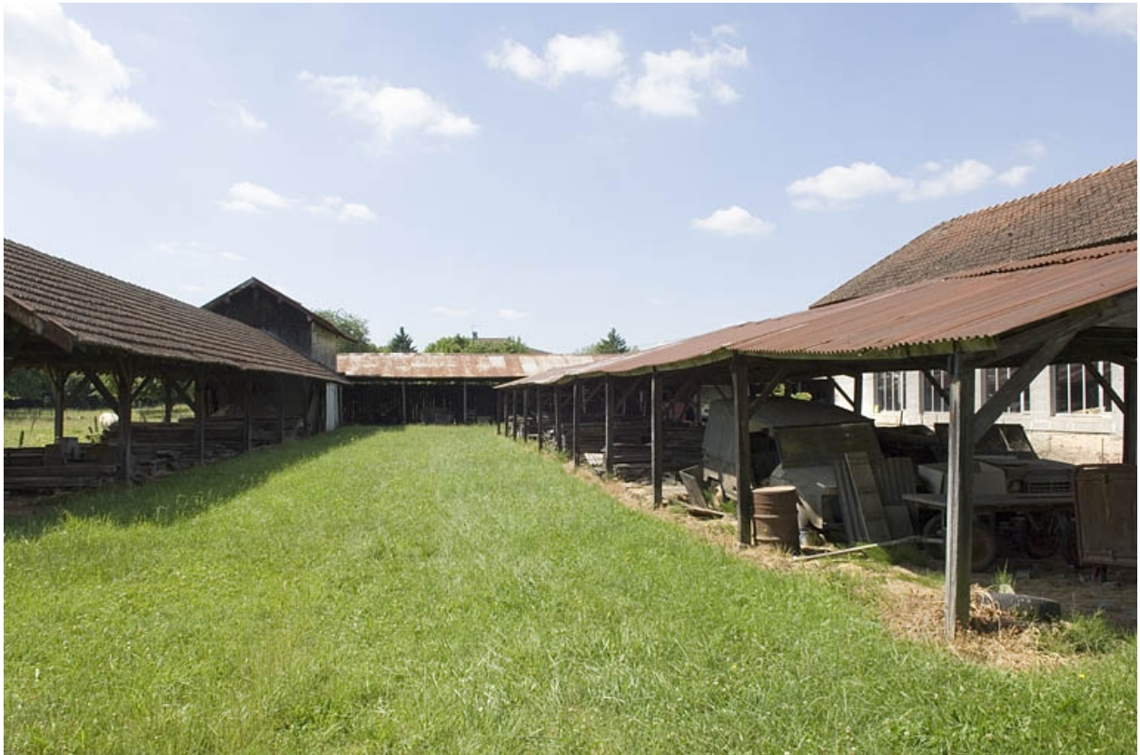
Entrepôts industriels sud.
