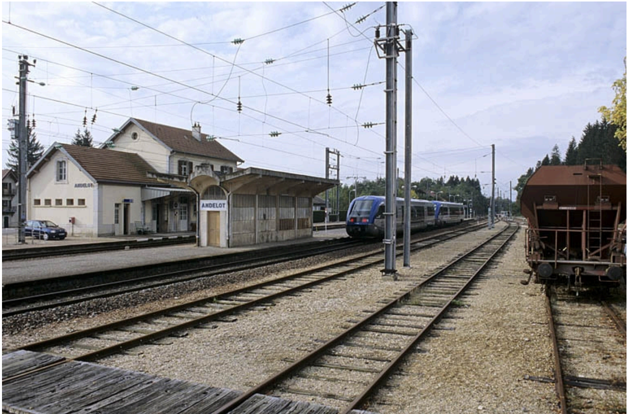
Vue d'ensemble, depuis le nord (voies côté Vallorbe).
