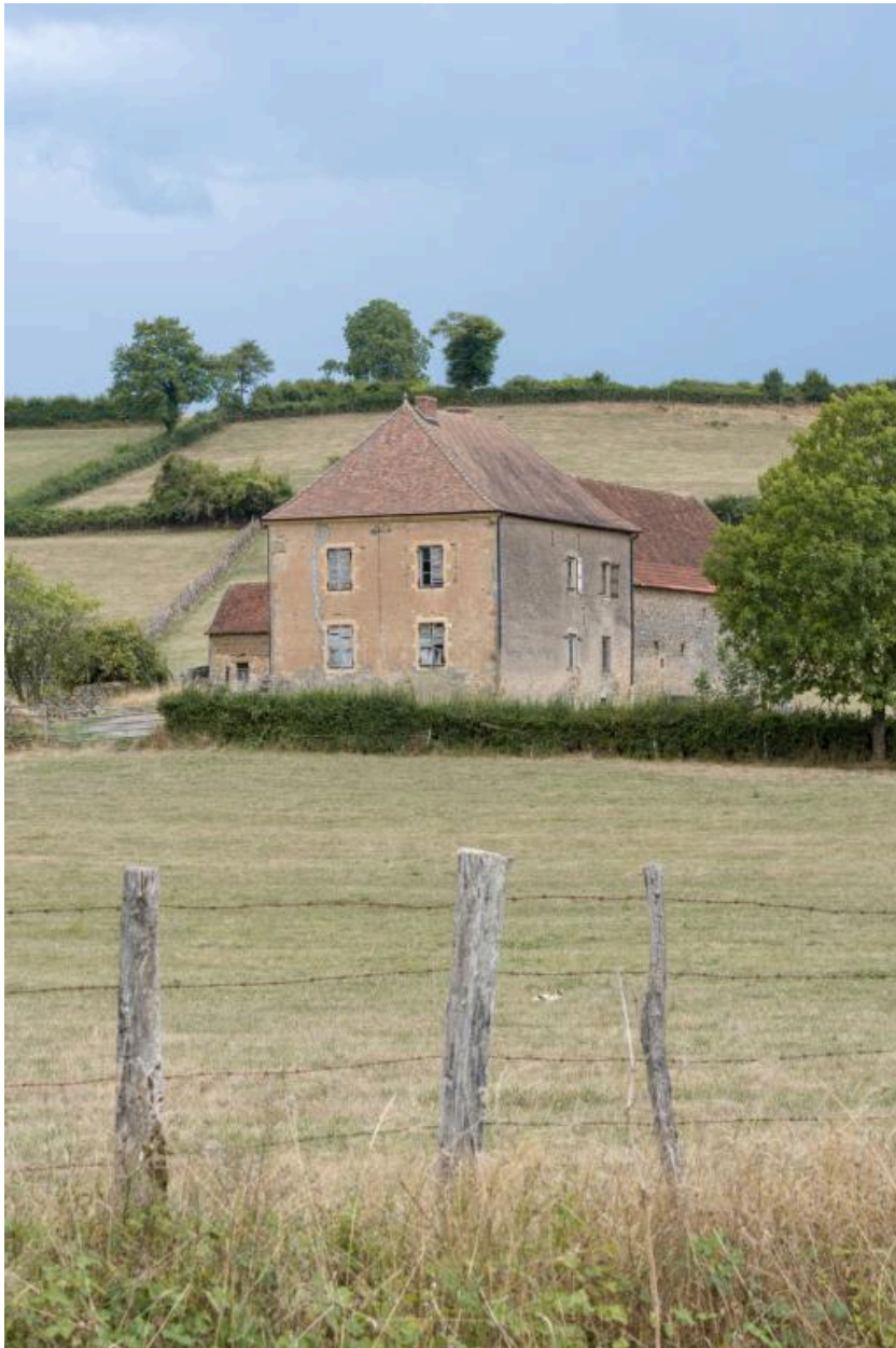
Vue de la ferme au nord-est
