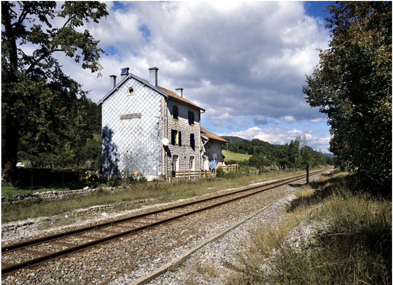
Vue d'ensemble, depuis le sud (façade postérieure).
