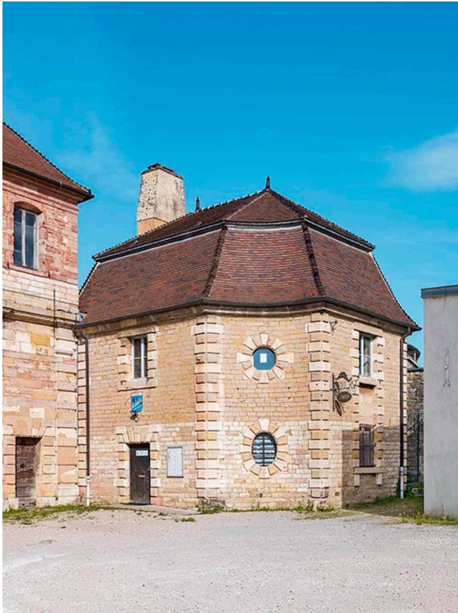
Détail du pavillon est.
