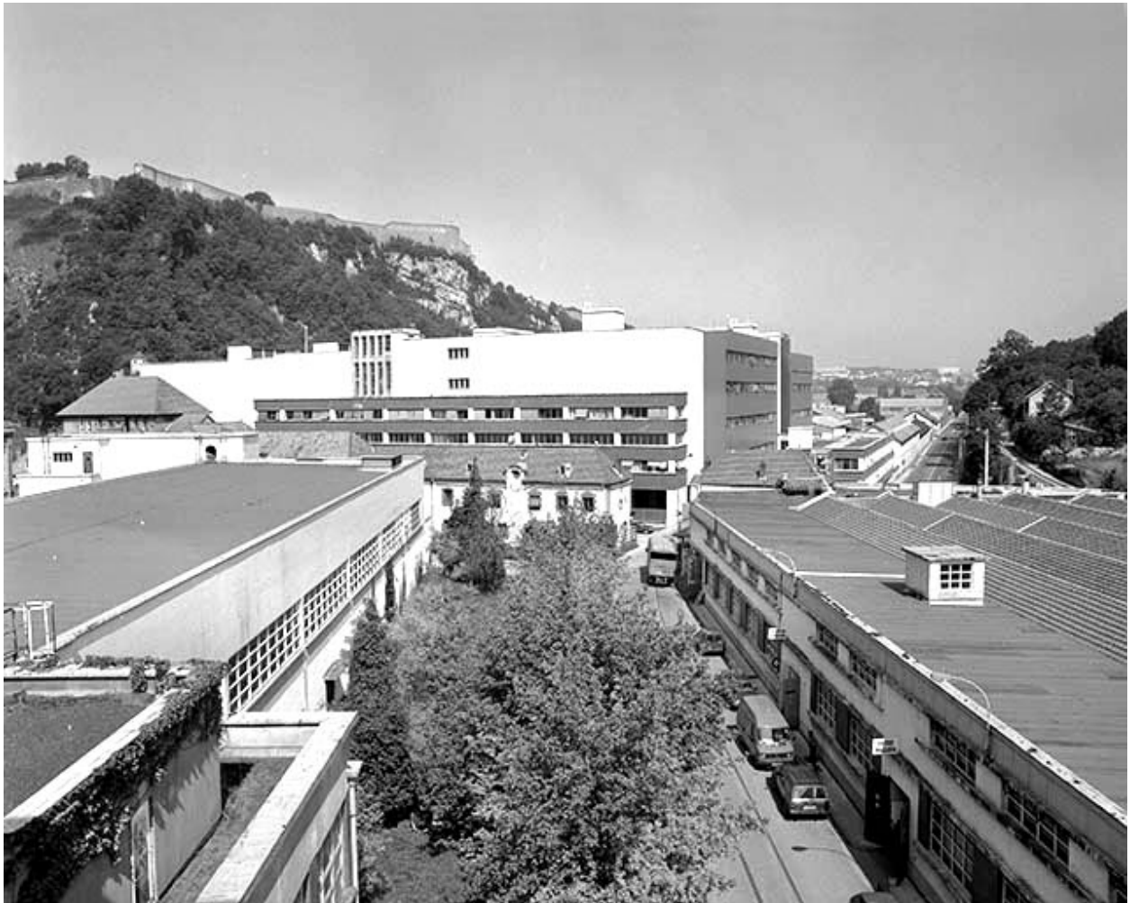
Allée centrale de l'usine A depuis le bâtiment de la 1ère filature tergal [TF1].
