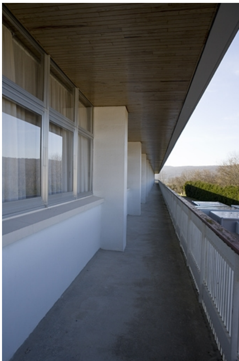
Internat : coursive extérieure à l'étage.
