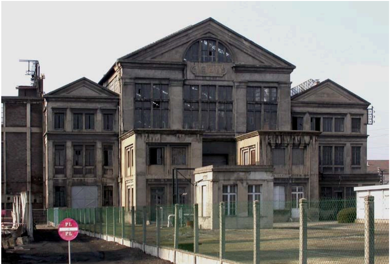
Elévation principale du bâtiments des alternateurs.
