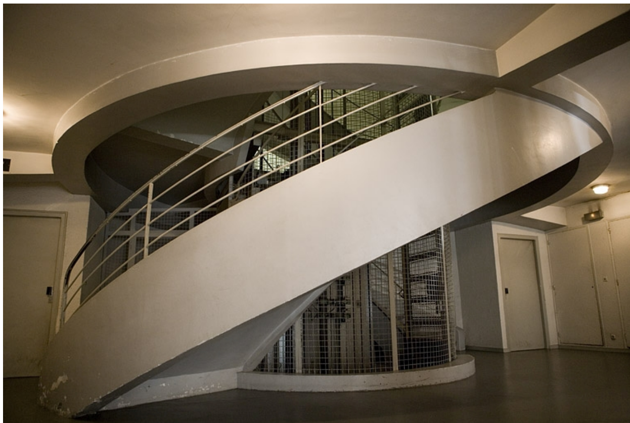
Escalier à double révolution.
