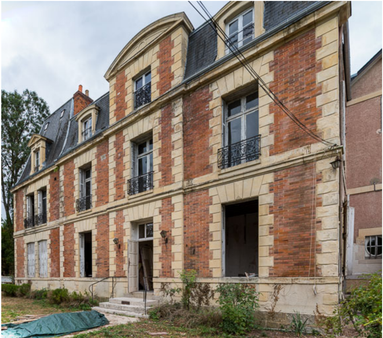
Façade sur l'avenue de Paris, vue de trois-quarts depuis le nord.
