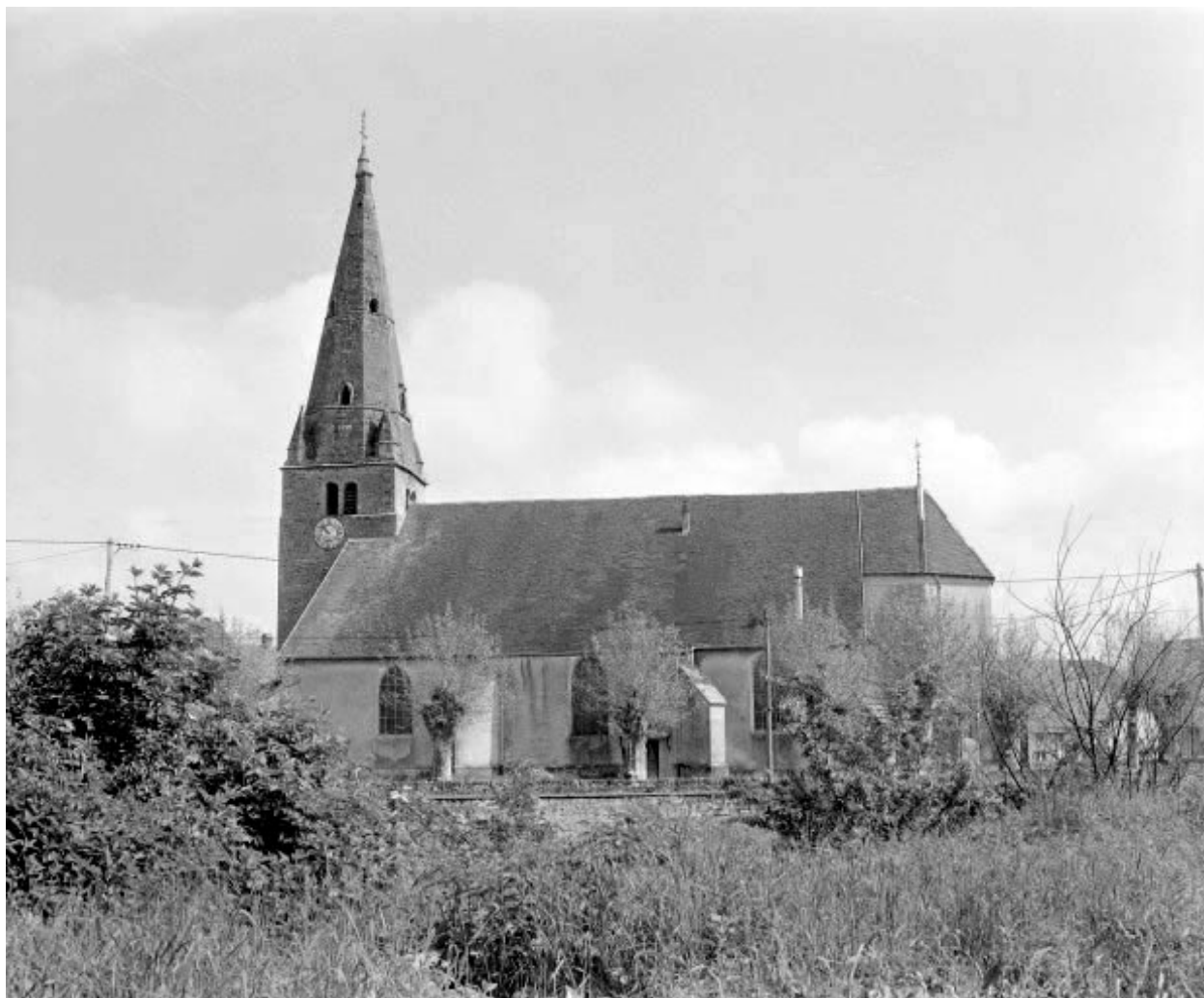
Façade latérale sud.
